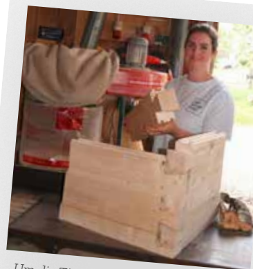
Um die Tiny Häuser zu bauen, wird ein Stecksystem mit Nut und Feder verwendet. Diese Bauweise ermöglicht es, das gesamte Haus nahezu komplett ohne Leim anzufertigen.
